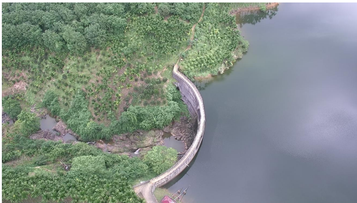
图 2-4 茅坡水库主坝上游坝面
