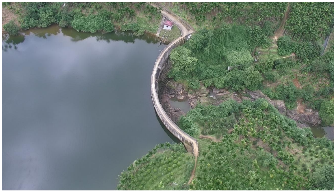
图 2-3 茅坡水库库区
