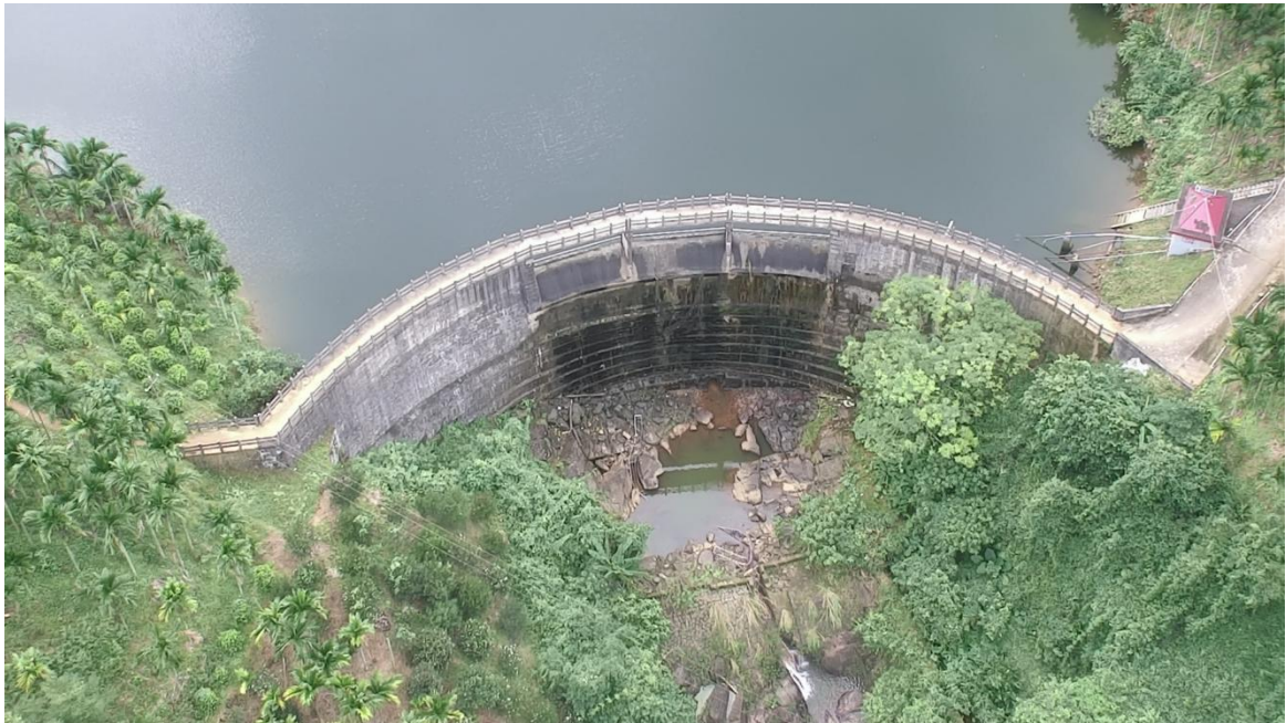
图 2-6 茅坡水库主坝下游坝面
