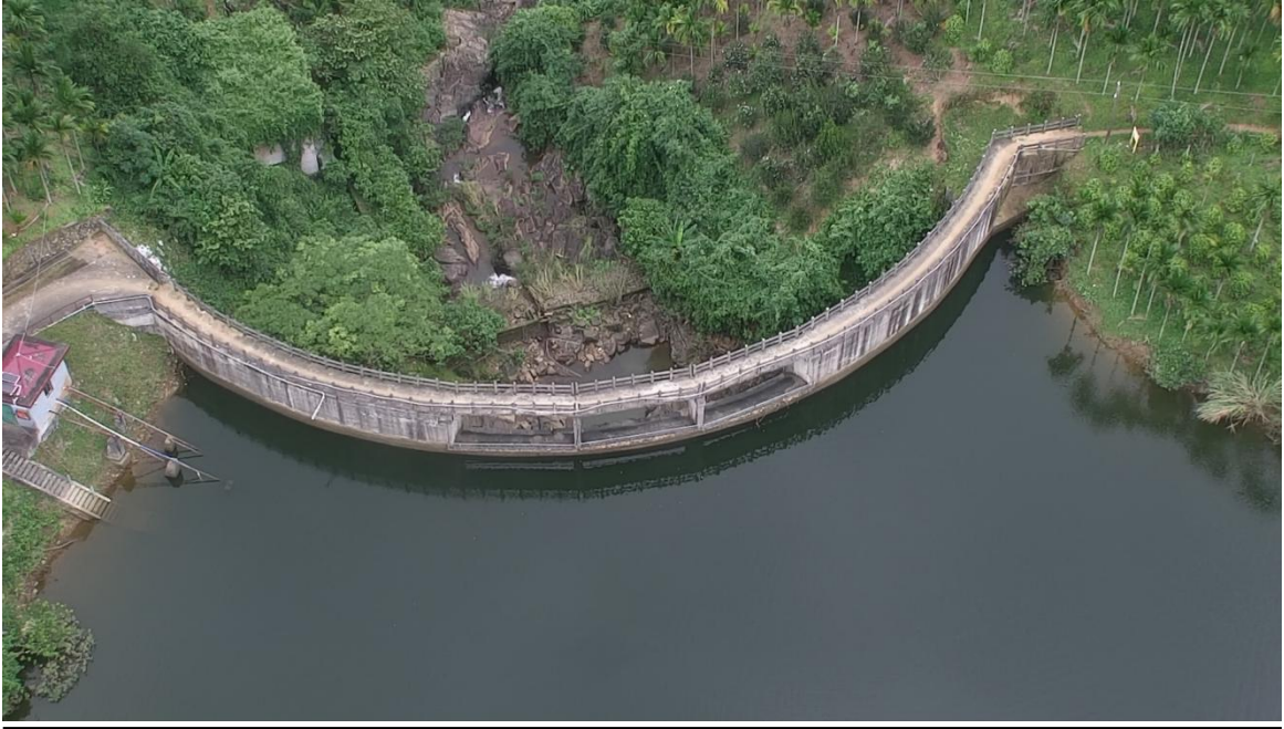
图 2-5 茅坡水库副坝
